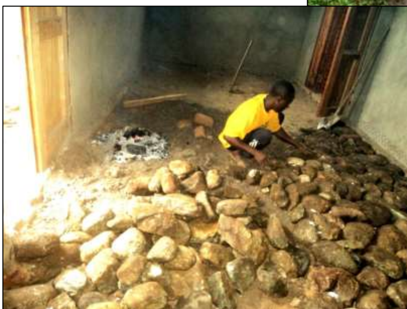
Posa in opera del secondo strato del pavimento
