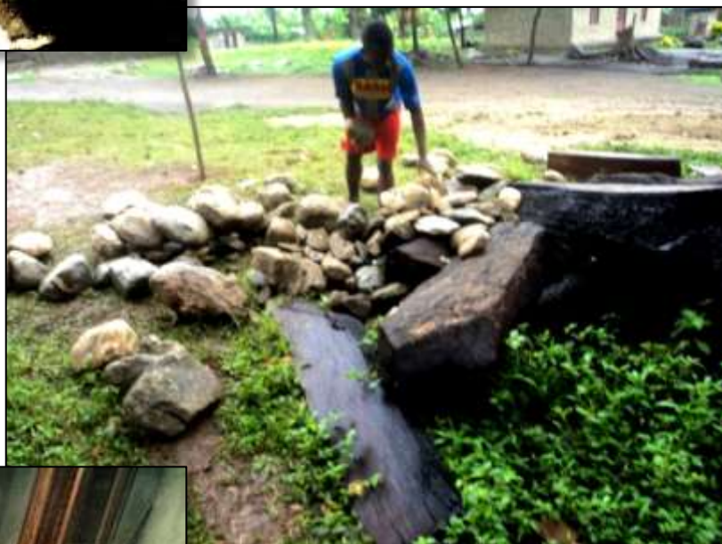
La scelta dei massi per il pavimento
