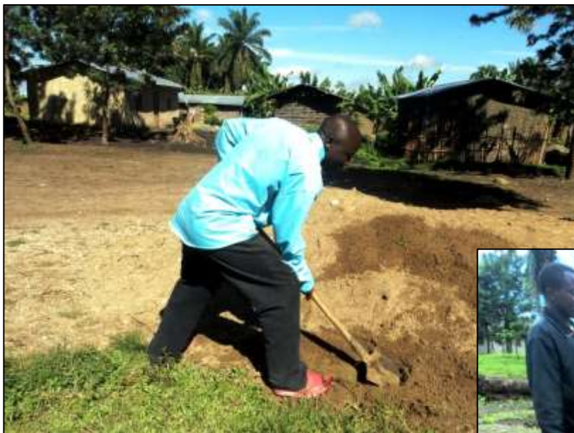
Preparazione del cemento
