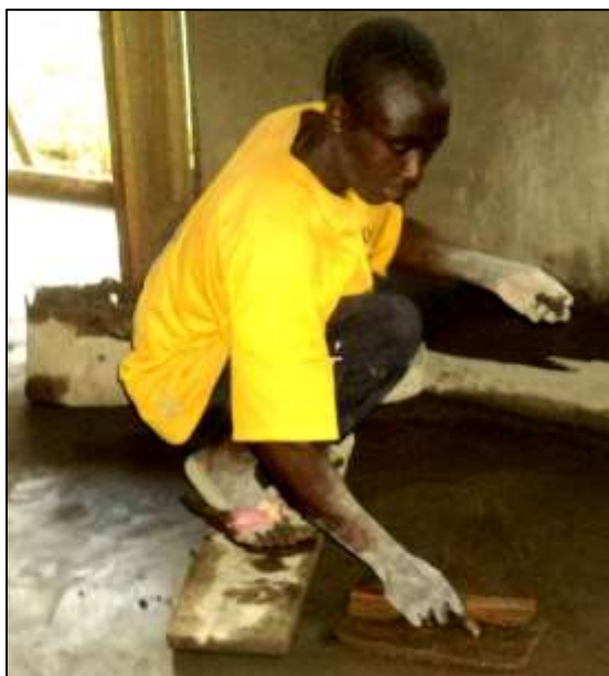
Livellamento del pavimento
