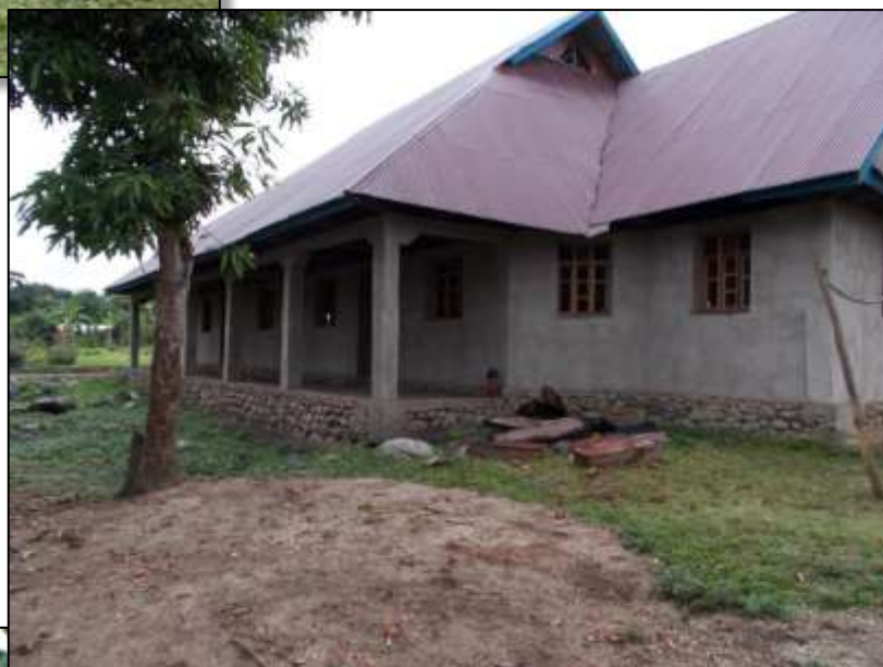
Fronte con porticato
