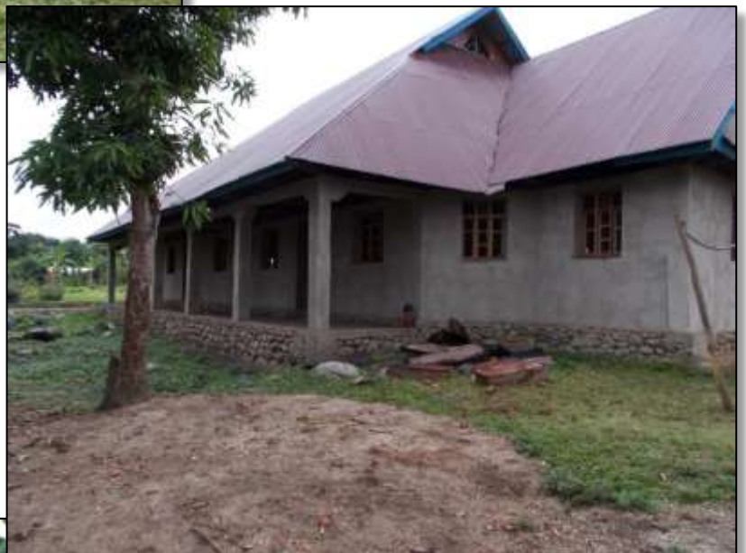
Fronte con porticato
