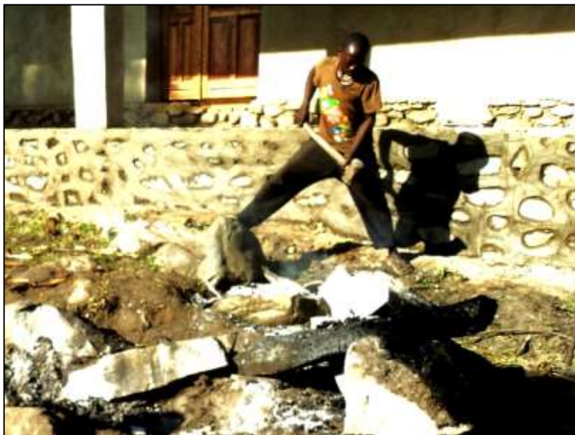
La preparazione dei massi per il pavimento
