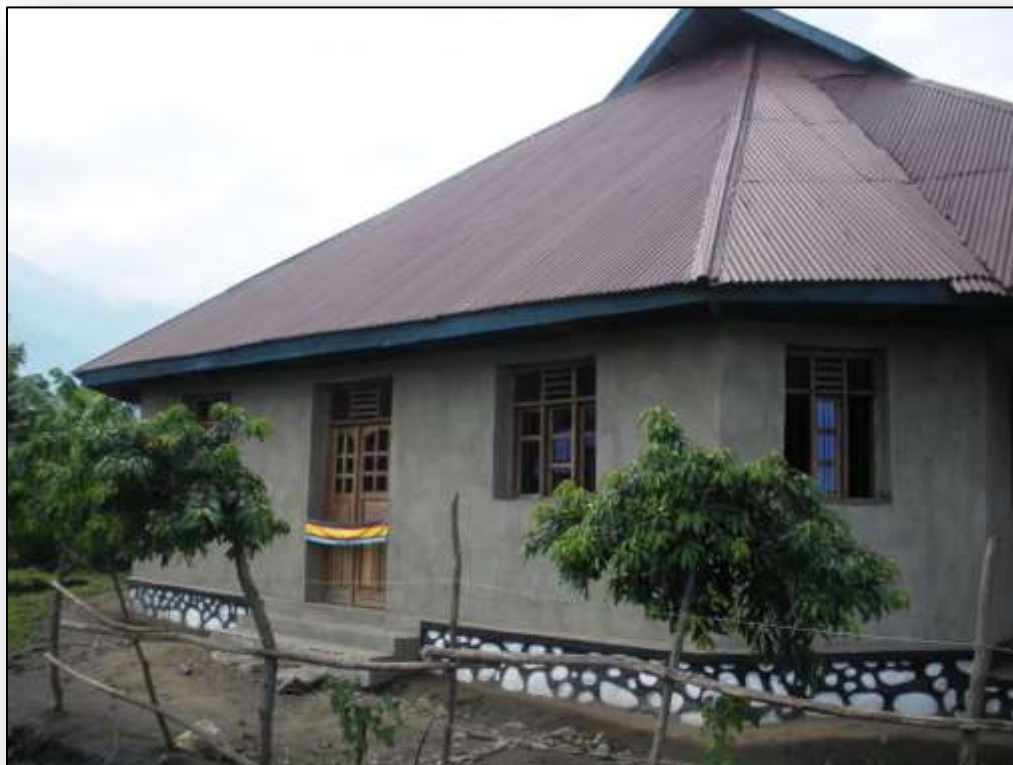
L'ingresso laterale sinistro prima dell'inaugurazione
