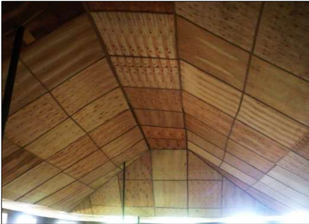
Il soffitto della sala principale
